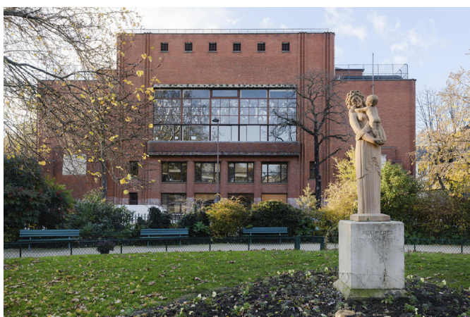
Annexe de la mairie du 14 e arrondissement qui accueillera provisoirement le Palais de Tokyo.
